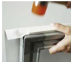
spingere il listello nella cava del profilo con un martello di gomma
